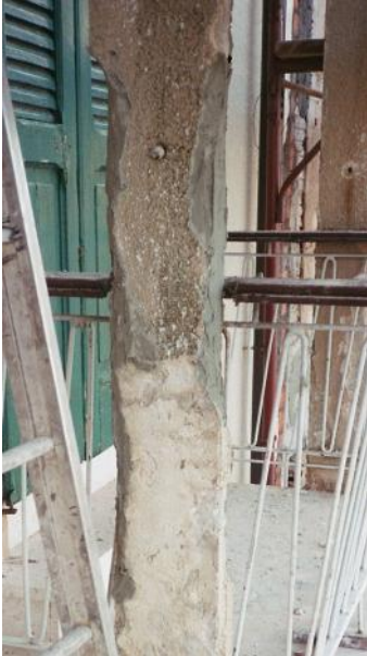
Sopra, un pilastro in fase di ricostruzione
